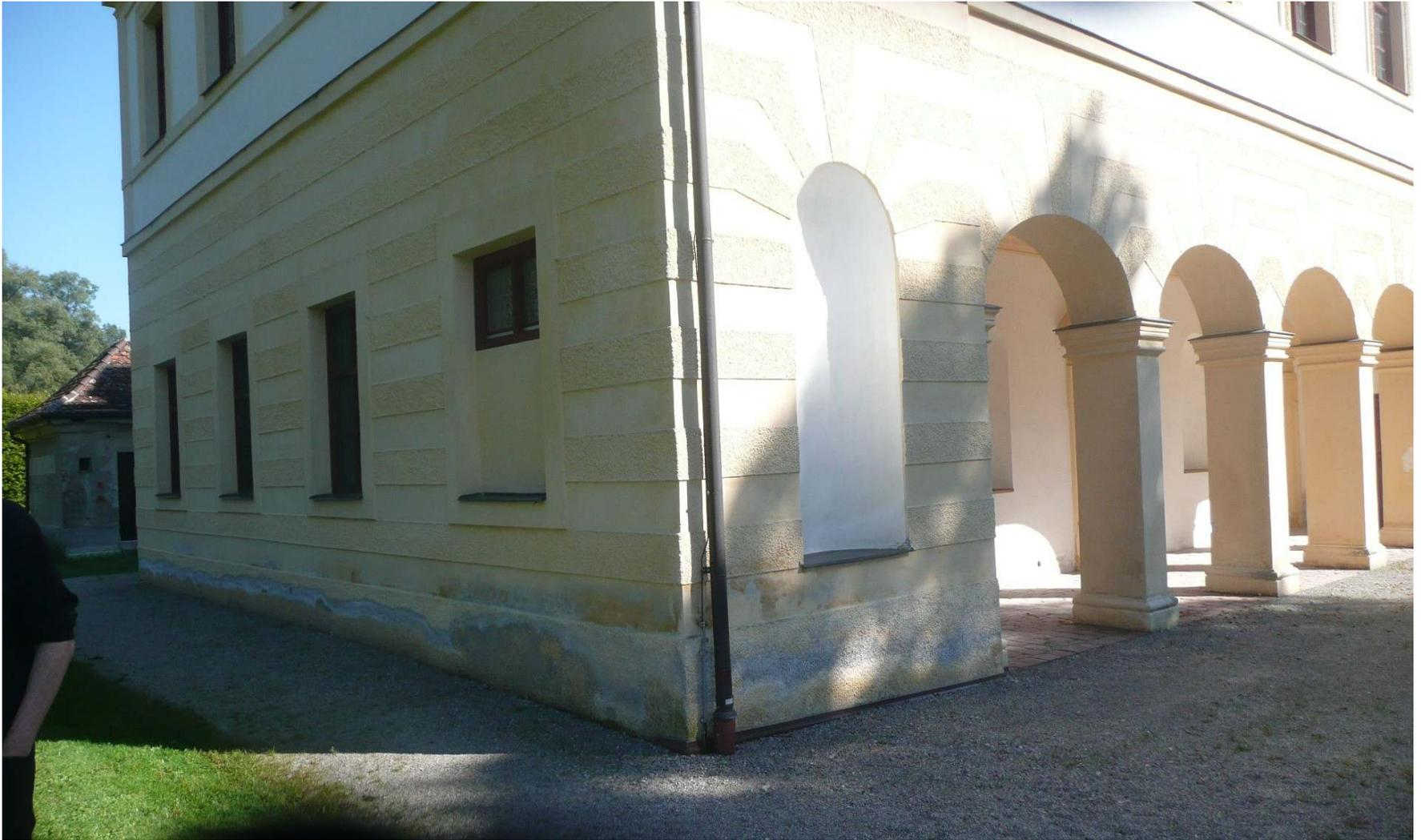
6 Jahre nach Sanierung: außen Putzschäden bis 1 m Höhe, innen bis 1,6 m
