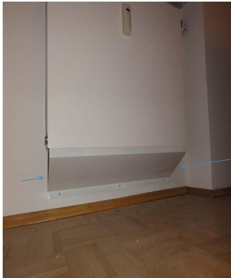
Kompaktheizkörper : Heizluft-Umlenkung durch Z-Profilblech (auch bei Nischenposition wirksam)
