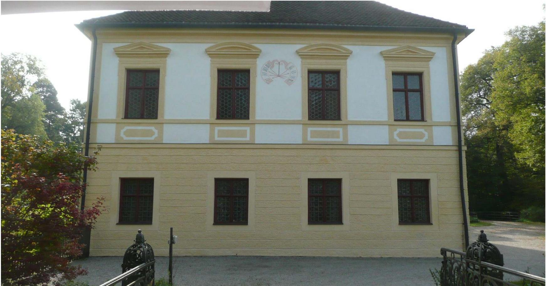
6 Jahre nach Sanierung: außen keine Putzschäden, innen keine Feuchteschäden
