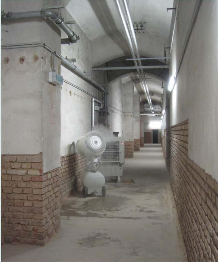
Basisbefeuchtung durch Sprühbefeuchter
