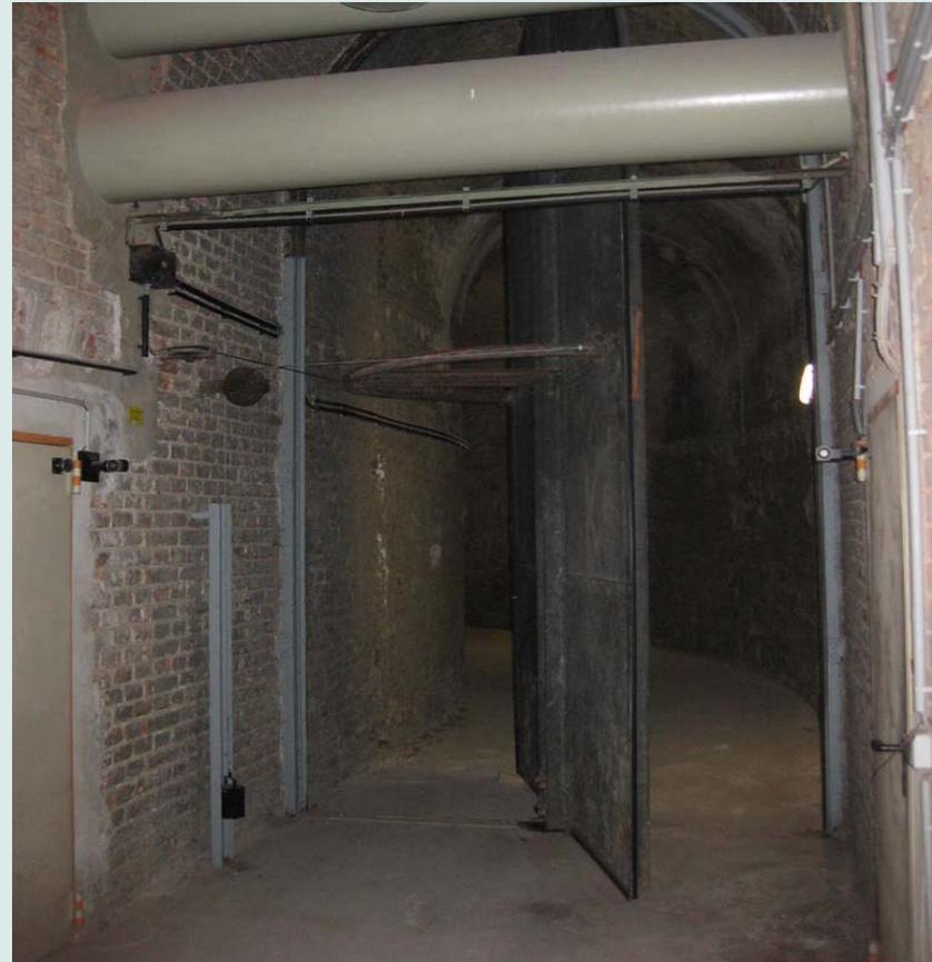
Drehtürsteuerung mittels Schrittmotor
