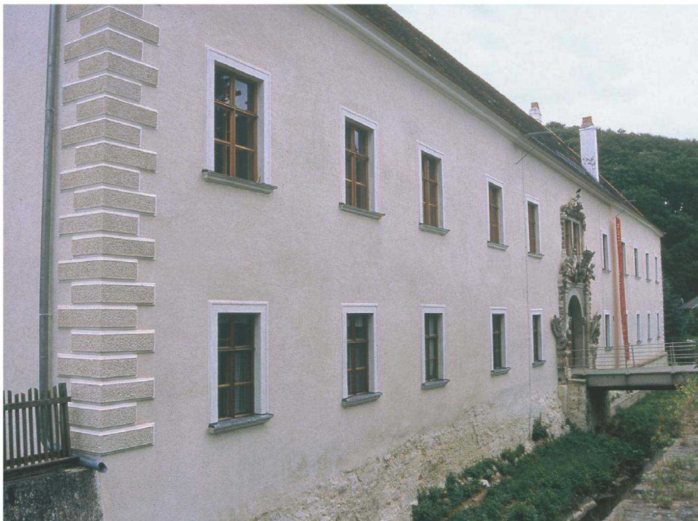
Die Karthause Mauerbach bei Wien: die Eingangsfront mit der dahinter liegenden Wohnung, die zu Beginn der 1990er Jahre mit einer Temperieranlage ausgestattet wurde. Die extrem dicken Mauern sind inzwischen trocken und zeigen auch an der Fassade keine Feuchtflecken mehr.
